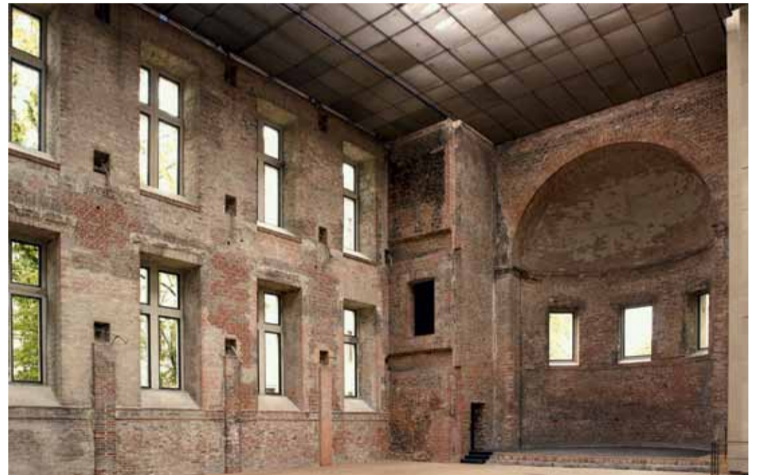
For [aɪskju:b] the whole St. Elisabeth church was darkened and deep blue filters were mounted to the roof lights. The deliberate reconstruction in the 1990s conserved the historic remnants in the church, which was bombed out in WW2. Für [aɪskju:b] wurde die komplette St. Elisabeth Kirche verdunkelt und die Oberlichter mit tiefblauer Folie verhängt. Der bedachte Wiederaufbau der Kirche nach der Wende, hat die Spuren der Zeit in der im Krieg ausgebombten Kirche erhalten. Image: Jürgen Frank/ Villa Elisabeth.
